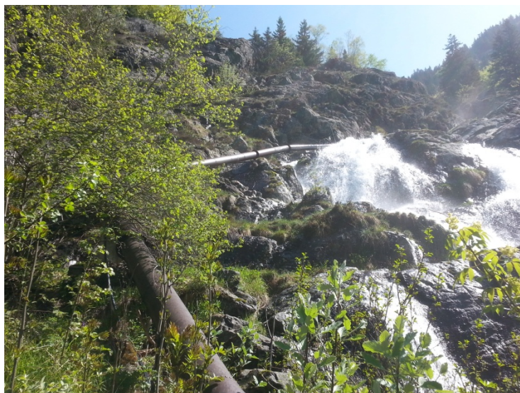
La prise d'eau et la conduite forcée à la fonte des neiges
