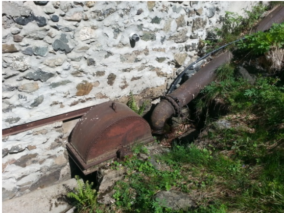
L'extrémité aval de la conduite forcée et la bêche.
