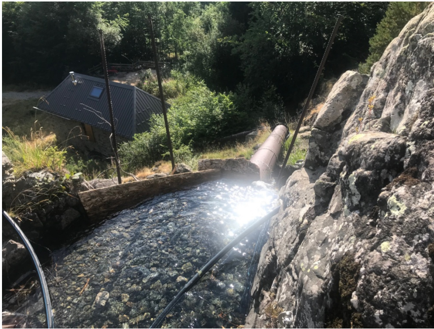
L'amont de la conduite forcée et la scie en-dessous
